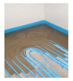
Aun siendo un mortero autonivelante, se debe **asegurar la total y homogénea repartición de la masa por toda la superficie**. Conforme vaya avanzando en la aplicación, puede alisar y aplanar la masa
